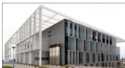
Gesamtansicht von Süden
